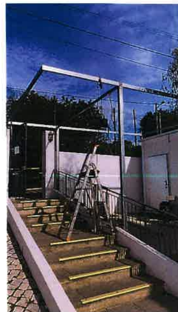
Imagem 12 - Reparação de Telheiro
