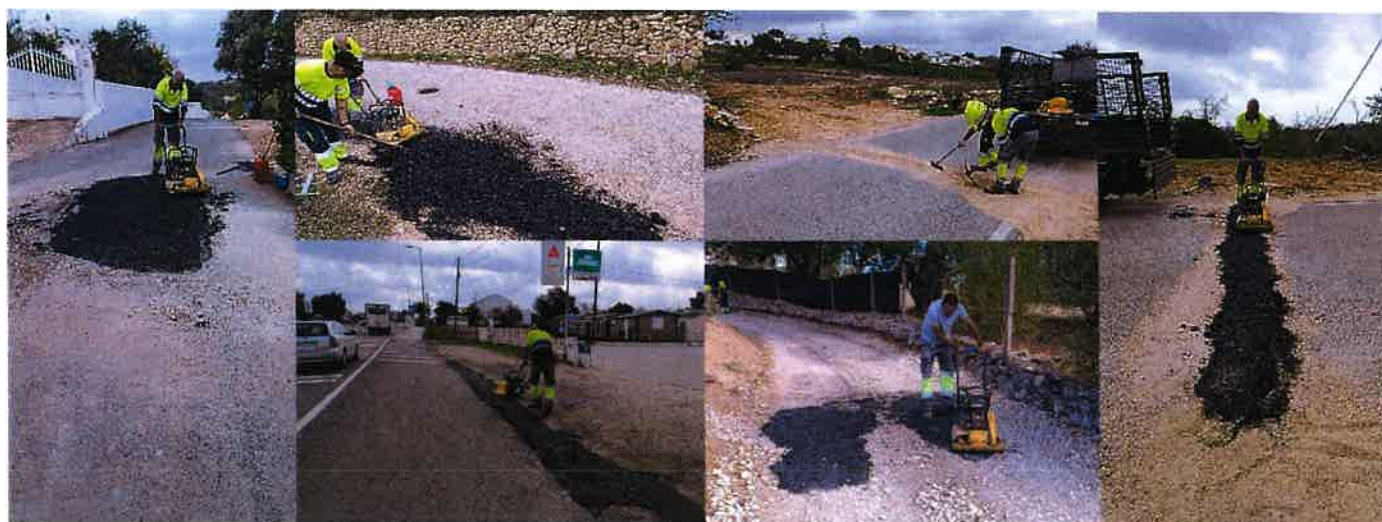
Imagem 8 - Colocação de alcatrão em vários pontos da freguesia
