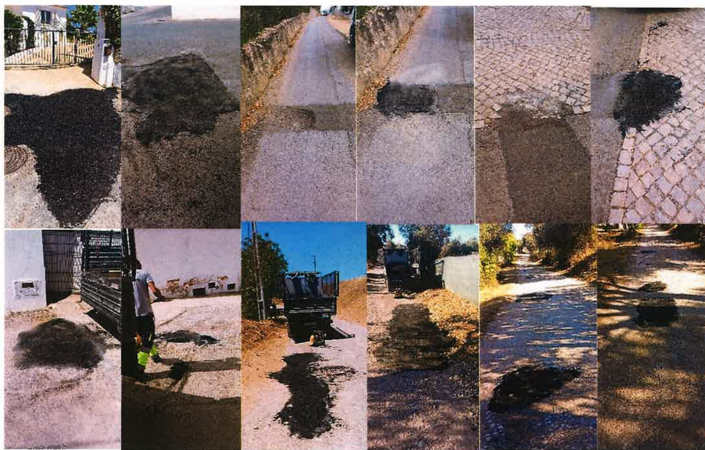
Imagem 13 - Colocação de alcatrão em vários pontos da freguesia
