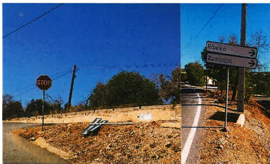
Imagem 6 - Manutenção da sinalização existente
