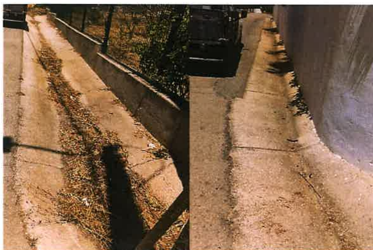
Imagem 7 - Limpeza de Valetas
