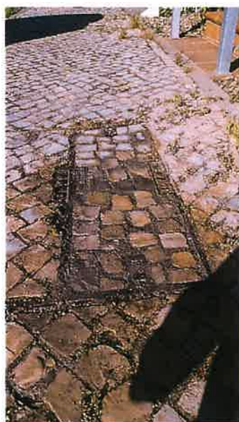
Fotos nº10 reparação de calçada
