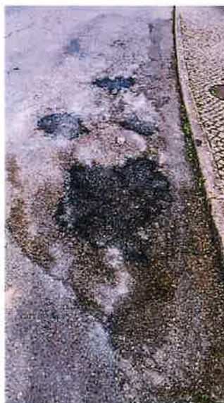
Fotos nº13, 14 e 15 Reparação temporária de danos no asfalto
