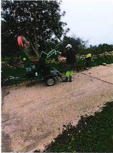
Fotos nº7,8 e 9 Limpeza de Bermas e Valetas com recurso ao Biotriturador e Braço corta-mato
