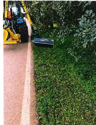
Fotos nº7,8 e 9 Limpeza de Bermas e Valetas com recurso ao Biotriturador e Braço corta-mato
