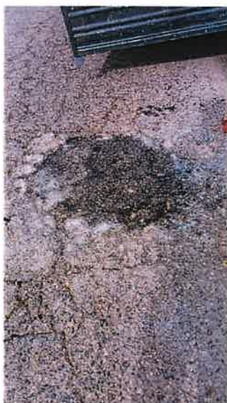
Fotos nº13, 14 e 15 Reparação temporária de danos no asfalto
