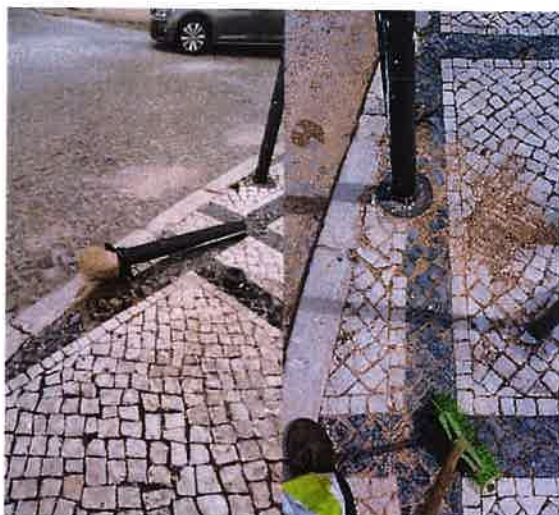
Imagem 12 - Recolocação de pino e reparação de calçada
