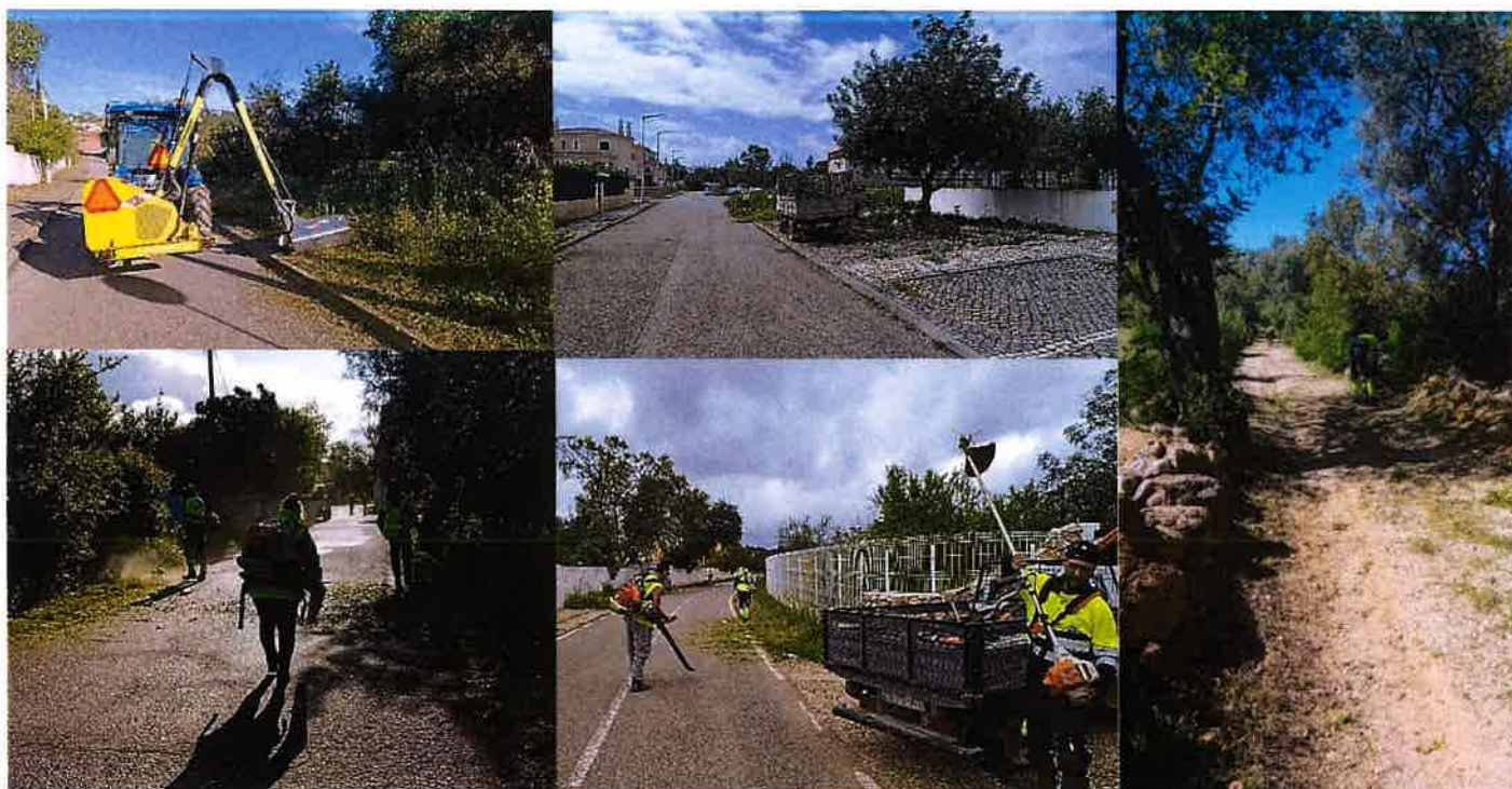
Imagem 15 - Limpeza de Bermas e Caminhos
