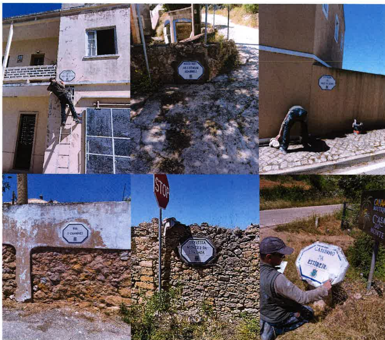
Imagem 10 - Colocação de Placas de Toponímia
