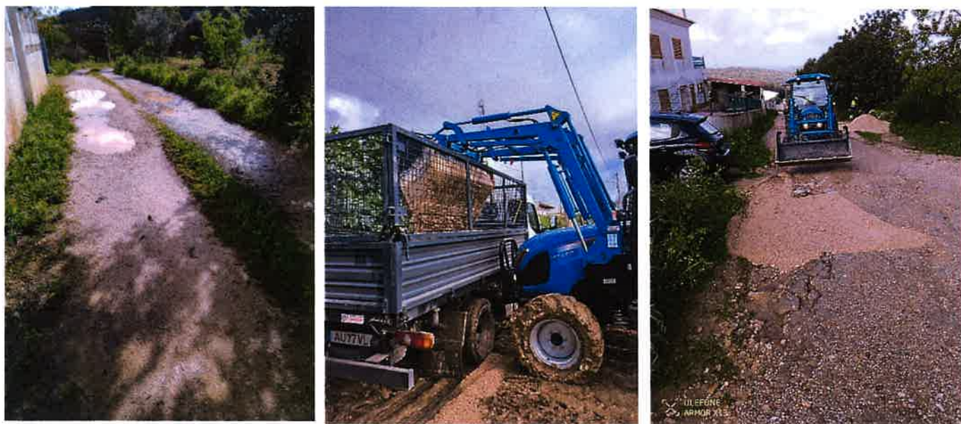
Imagem 9 – Reparação de caminho com recurso a tout-venant.
