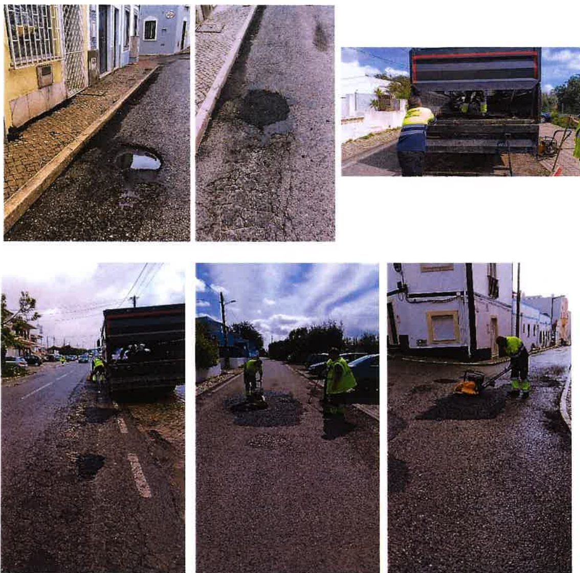
Imagem 10 – Reparação de vias com recurso a alcatrão.
